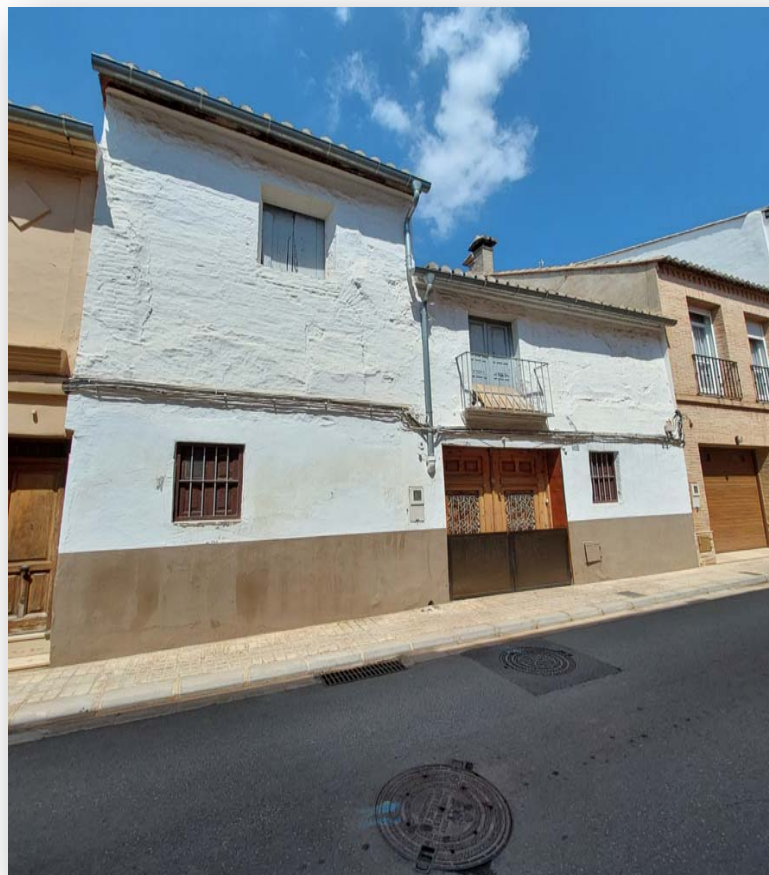
FOTO 4. Casa de la Torreta, antigua torre vigía en Benifaraig
