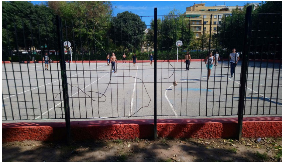
FOTO/s: Problemas detectados: rotura de vallas.
