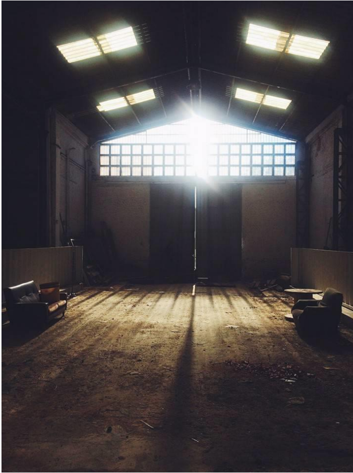
Imagen de l'interior de la fàbrica abans de la rehabilitació. Font: https://valenciaplaza.com/valencia-descongelada-la-leyenda-de-la-fabrica-de-hielo-entra-en-calor
