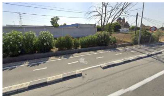
Carril bici paralelo a la Carretera del Río
